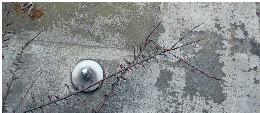
Bild 1. Glasfaserverstärkter Kunststoff: durch Außenwitterung gealtertes GFK mit zerstörter Oberfläche (© werkstoff&struktur)
